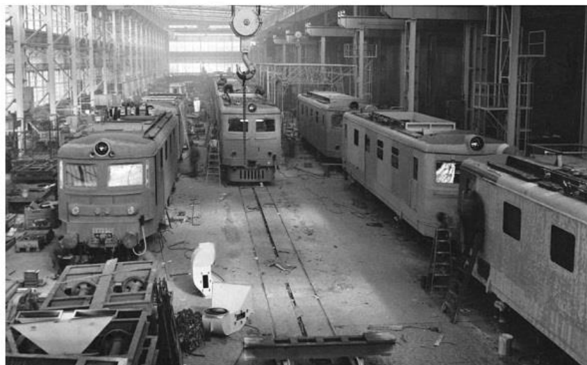
Pohled do výrobní haly závodu Škoda Plzeň v roce 1960. Právě zde probíhá montáž lokomotivy ČS1, tedy modifikace naší E 499.1 pro Sovětský svaz. Za parádní stájí vlevo stojící rozestavěná jedna ze dvou lokomotiv typu E 479.0 pro ČSD, která příštího a rok později zahájí éru našich jednotsových lokomotiv na prvním úseku napájeném střídavou trakční soustavou 25 kV, 50 Hz mezi Plzní a Blovicemi. (fotografie foto Škoda, SOA Plzeň)
