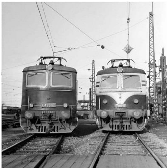
Seřazení strojů E 499.101 a 60 v depu Praha hl. n. krásně umožňuje porovnat vzhledové rozdíly mezi „nulkovými“ Bobinami, jejichž podobu představuje mazistupně v podobě stroje 101, a sériovými „jednicovými“ Bobinami. (foto Ing. Jaramír Kozínka)
